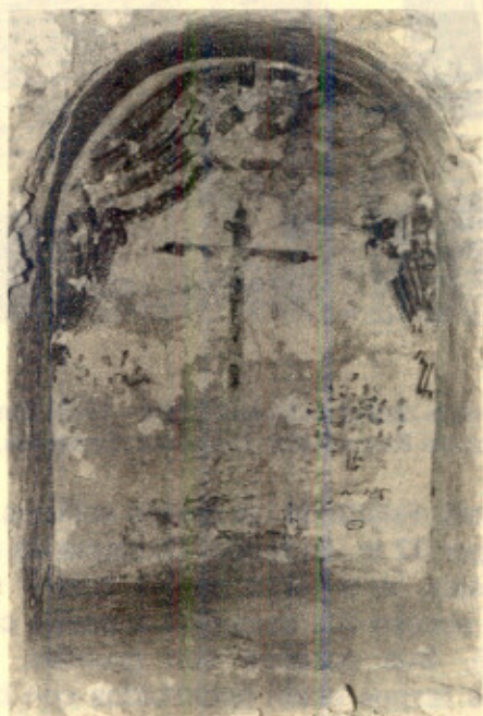
Detalle del interior del nicho.
