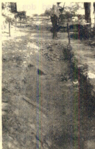
Aspecto del basamento oculto bajo la banqueta de la fachada principal.
