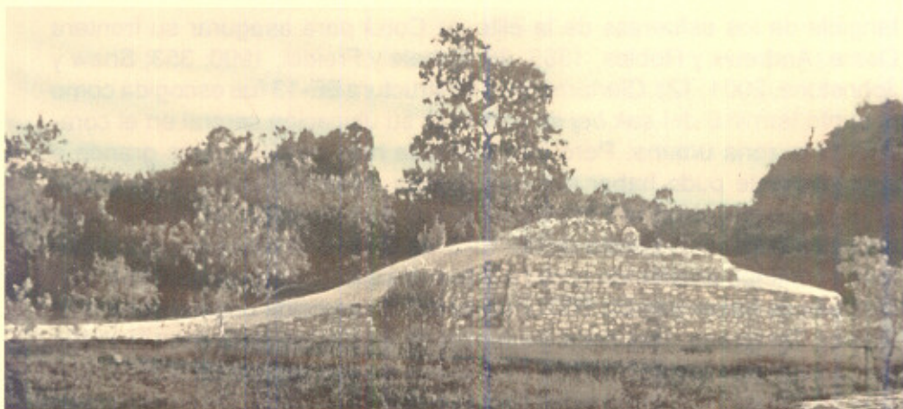
Figura 5. Estructura. 6E-13 después de consolidación, 2001.
